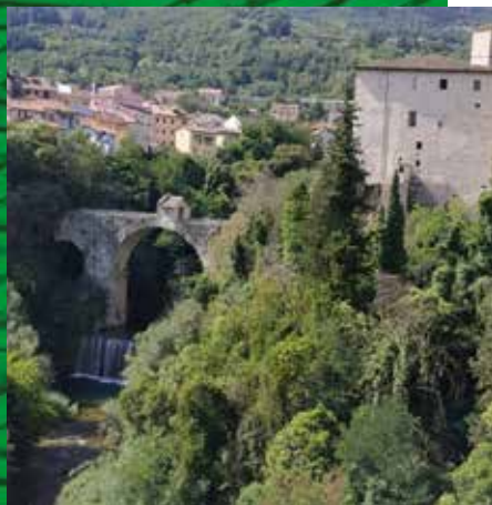
PONTE DI CECCO E TORRENTE CASTELLANO
