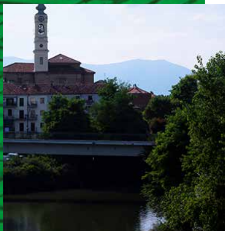
PASSERELLA CICLOPEDONALE MAZZINI E CENTRO STORICO
