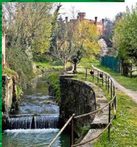
EX CONCA DI NAVIGAZIONE. SOSTEGNO DI CORTICELLA
