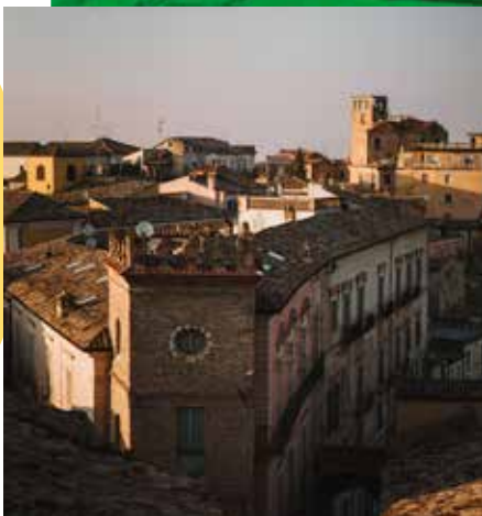
VISTA SU TORRE DE TOPPI E TORRE DEL PALAZZO MEZZANOTTE
