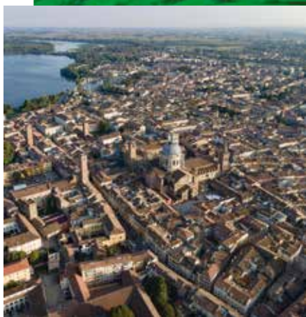
MANTOVA - VISTA AEREA
